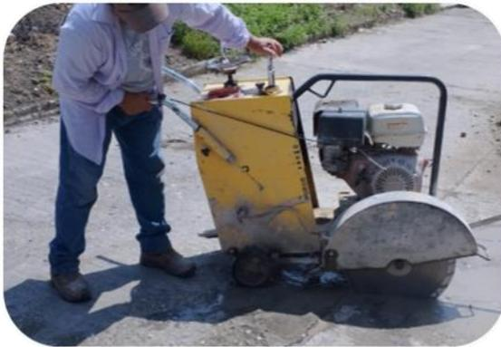
**Fotografía 3:** Corte de pavimento por fundición.
