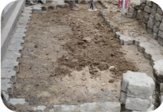
• **Fotografía 1:** Levantado de adoquín por hundimiento
