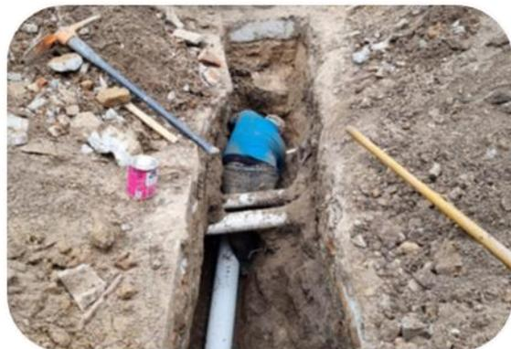
**Fotografía 4: Instalación de Servicio de Alcantarillado Sanitario**
