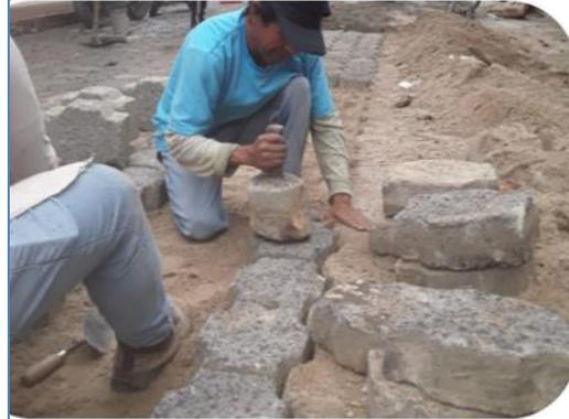
**Fotografía 2:** Levantado de adoquín por hundimiento
